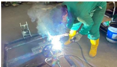
(図2) アーク溶接作業
