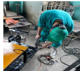
(図3) 電気ドリルでの穴開け作業
